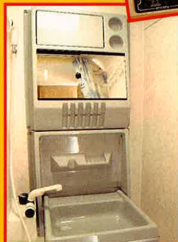
Alles da: Klappwaschbecken und Spiegelschrank im Sanitärbereich.
